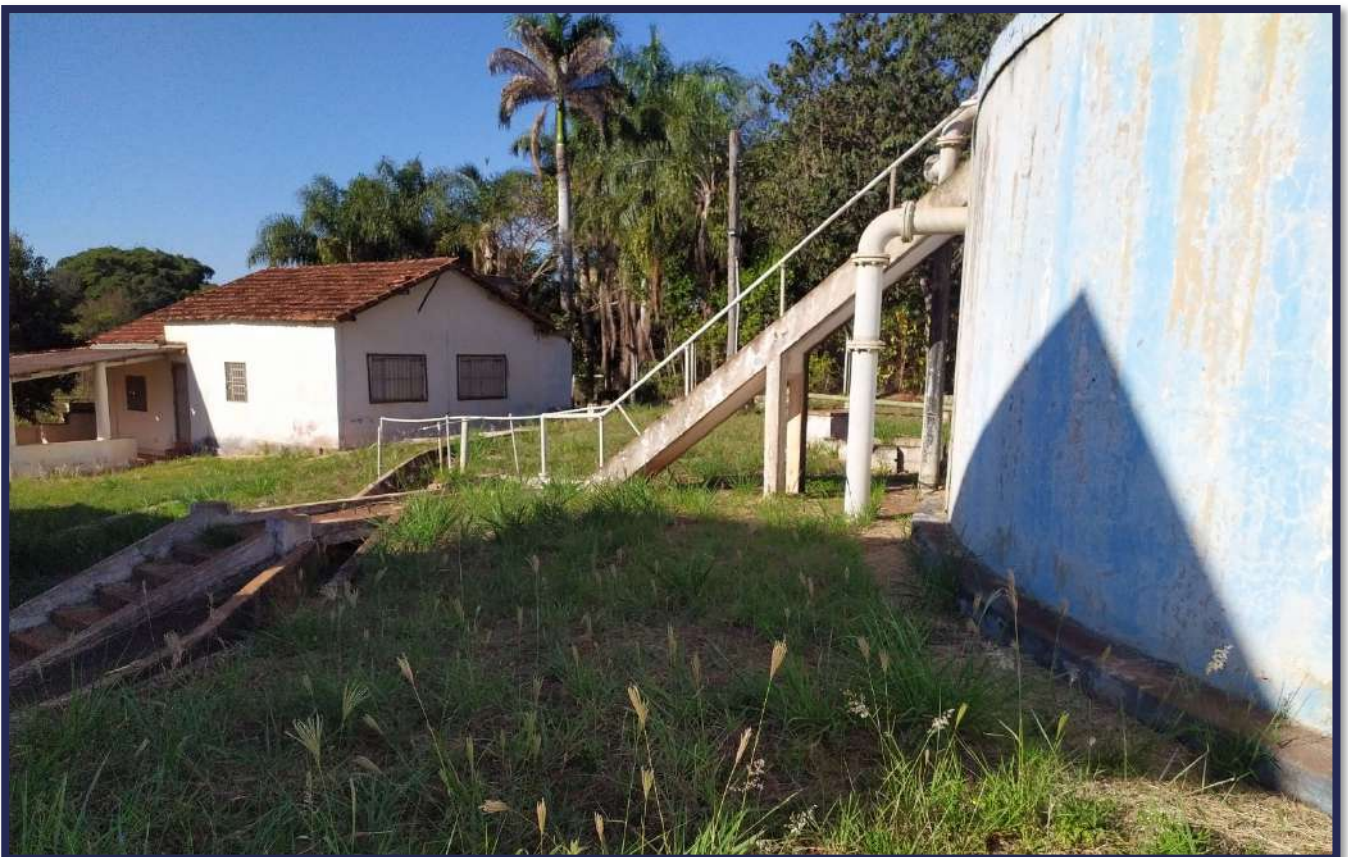
Figura 3-44 - Vista atual das instalaes do Reservatrio 03.
