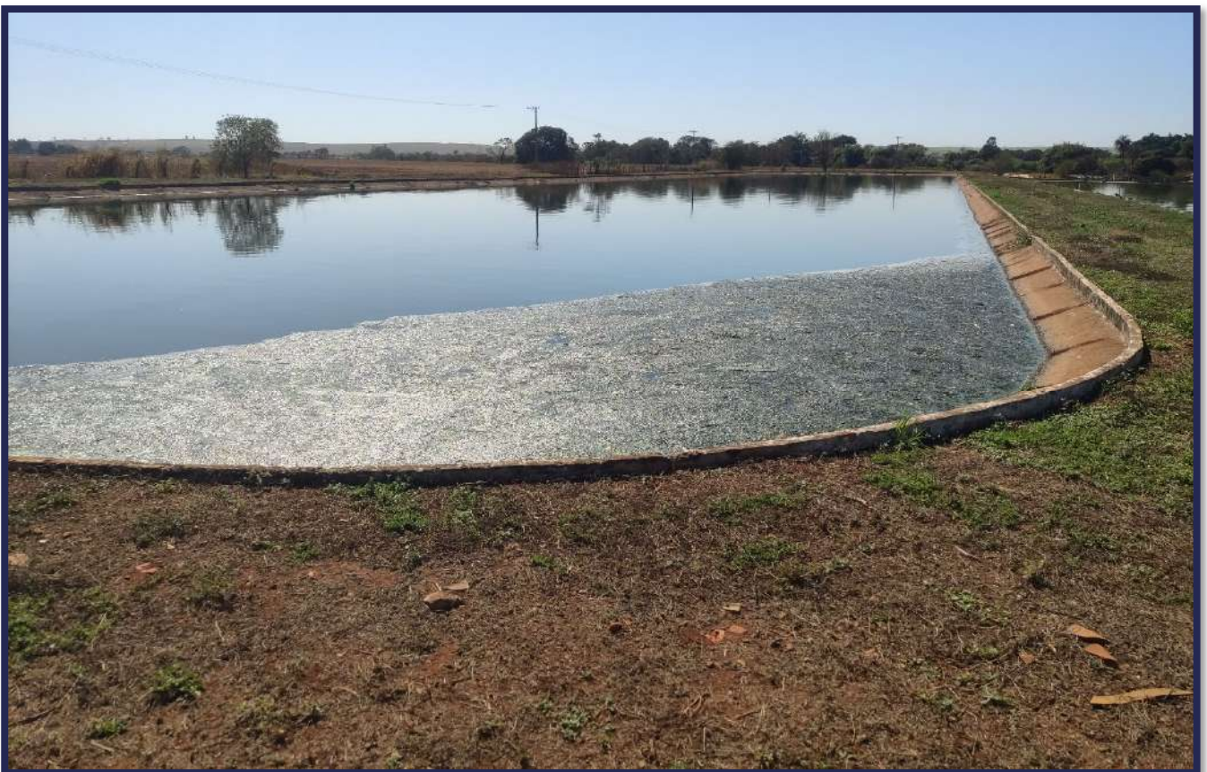
Figura 4-20 - Vista atual das instalações da ETE Vacariú.
