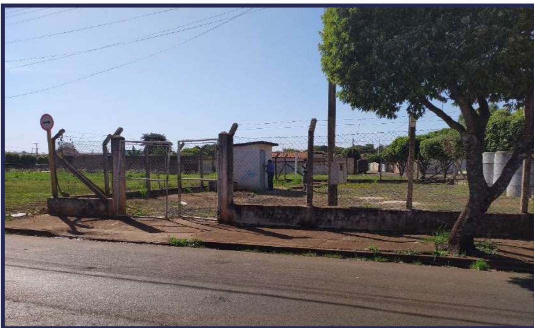
Figura 4-13 - Vista atual das instalaoes da EEE 07 de Setembro.
