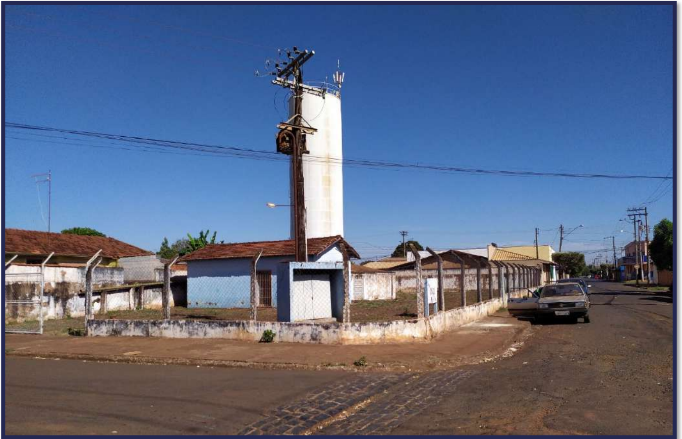
Figura 3-40 - Vista atual das instalaes do Reservatrio 02.
