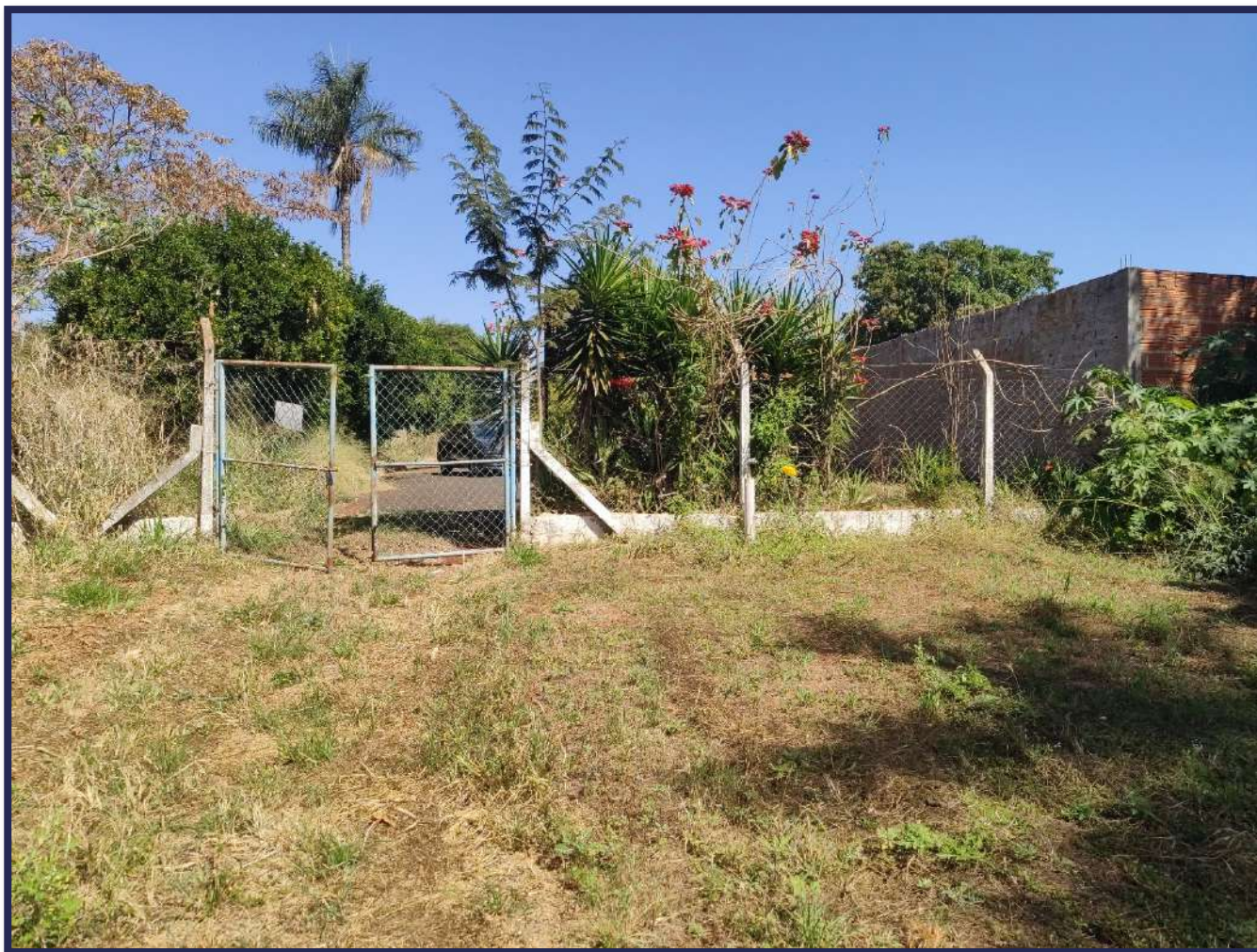
Figura 4-24 - Vista atual das instalaes da ETE Pioneiros.
