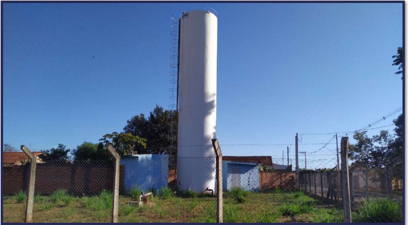
Figura 3-48 - Vista atual das instalaes do Reservatrio 12.
