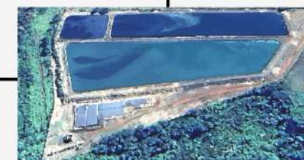
ETE VACARIÚ 170m³/h
