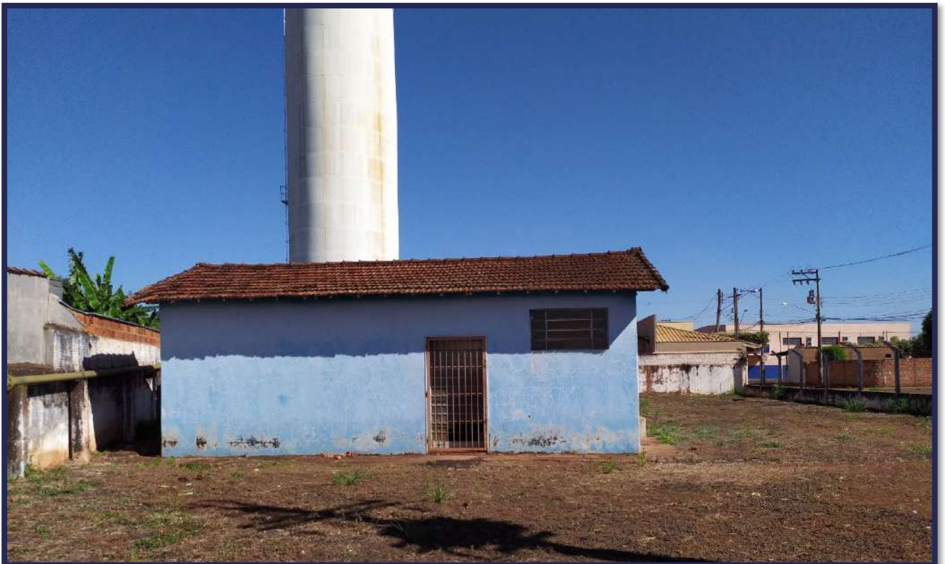
Figura 3-41 - Vista atual das instalaes do Reservatrio 02.
