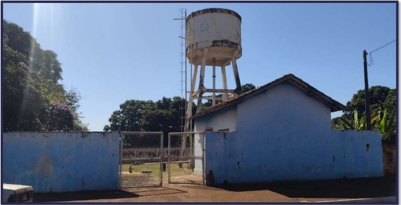
Figura 3-62 - Vista atual das instalaes do Reservatrio Pioneiros.
