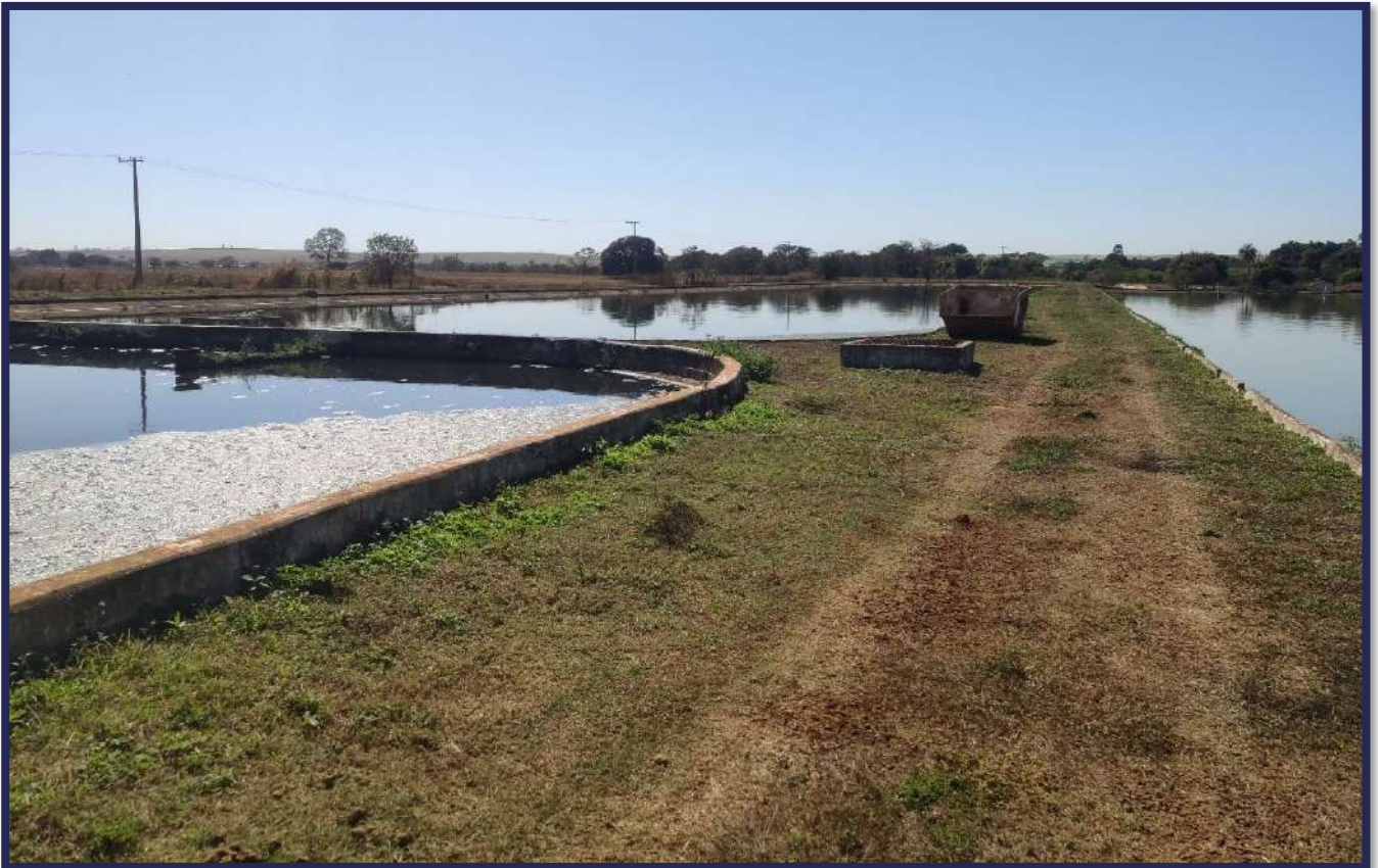
Figura 4-19 - Vista atual das instalações da ETE Vacariú.
