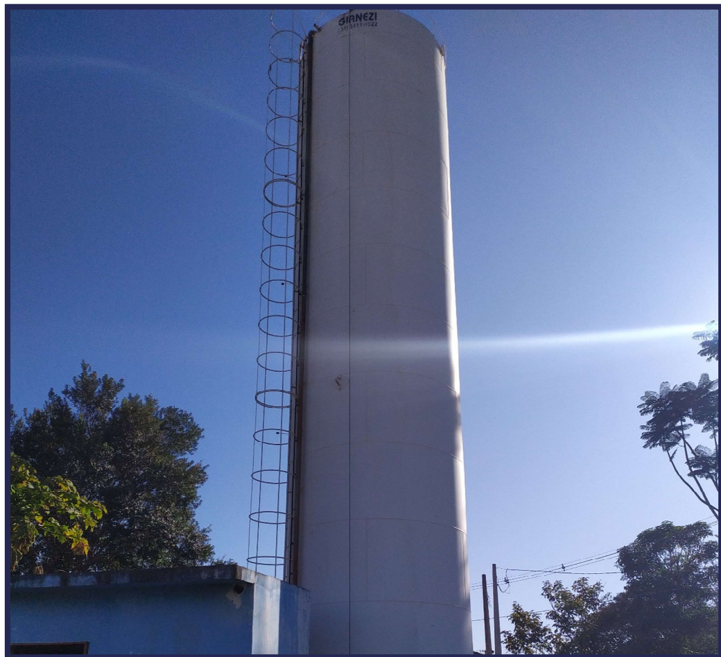
Figura 3-49 - Vista atual das instalaes do Reservatrio 12.
