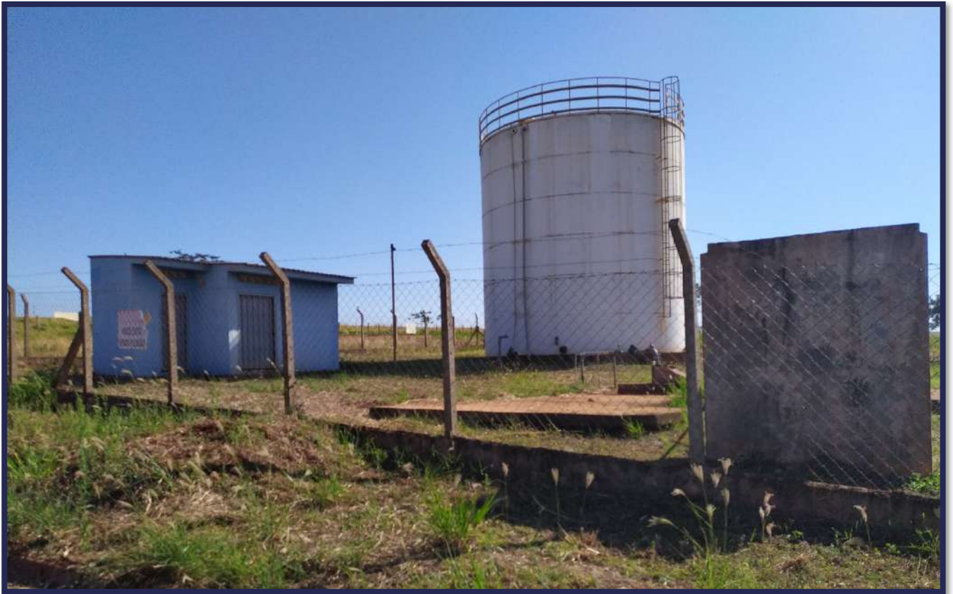
Figura 3-37 - Vista atual das instalaes do Reservatrio 11.
