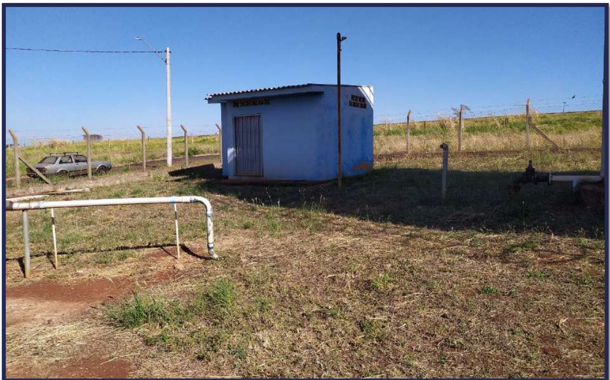
Figura 3-12 - Vista atual das instalaes do Poo 11.
