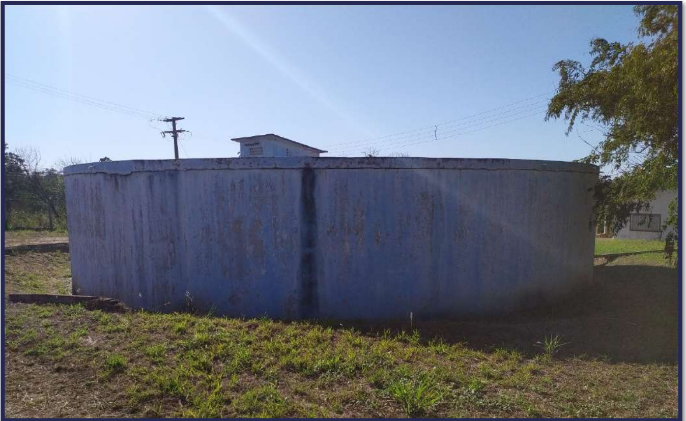
Figura 3-43 - Vista atual das instalaes do Reservatrio 03.
