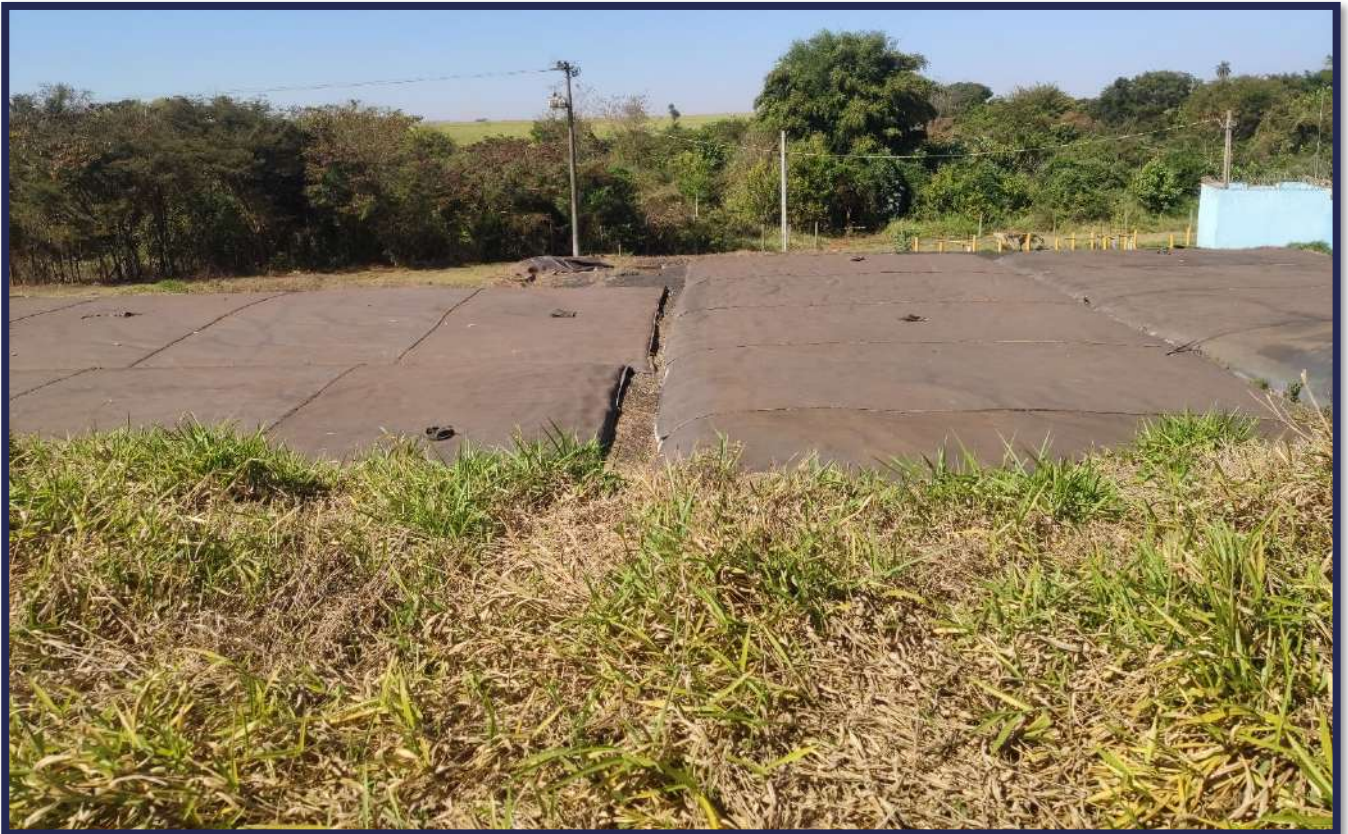
Figura 4-21 - Vista atual das instalações da ETE Vacariú.
